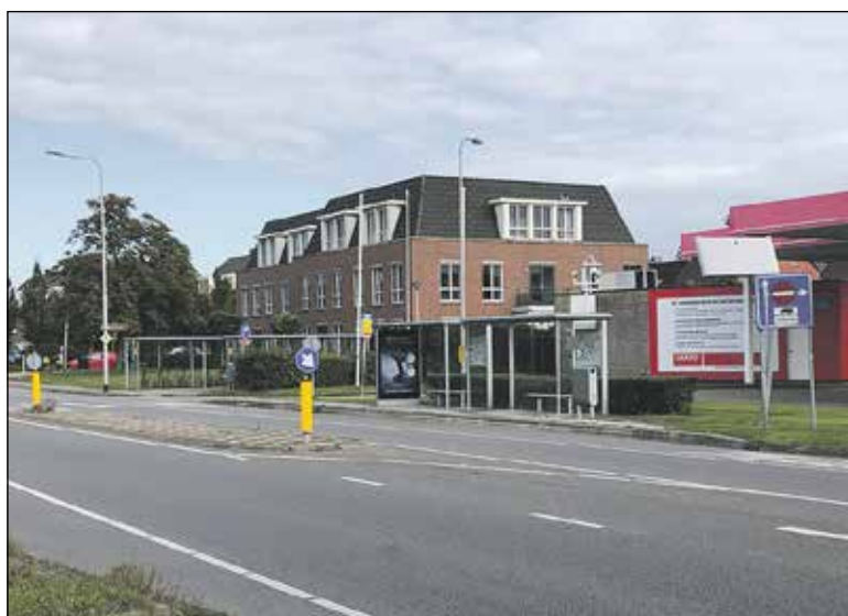
De huidige plaats van de bushalte
