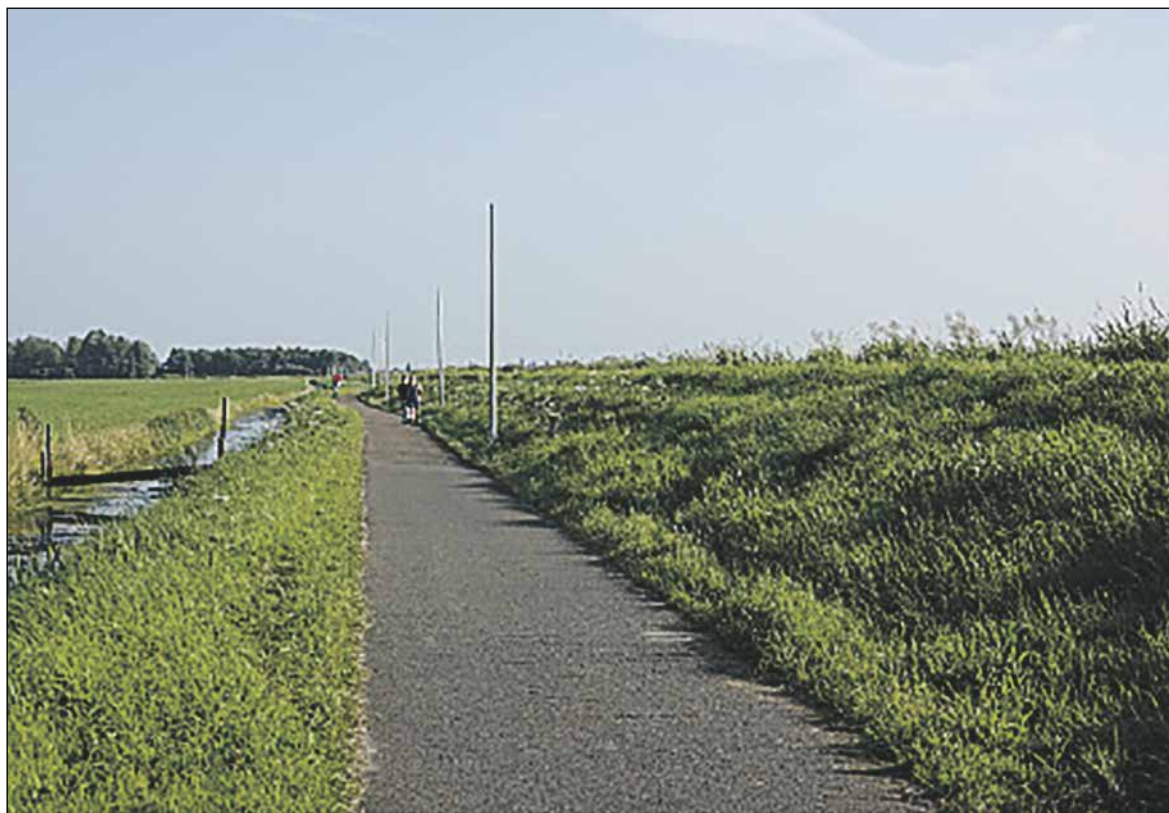
De palen staan al. De zonnepanelen met LED lampen moeten er nog op gezet worden. Foto Diana Baak
