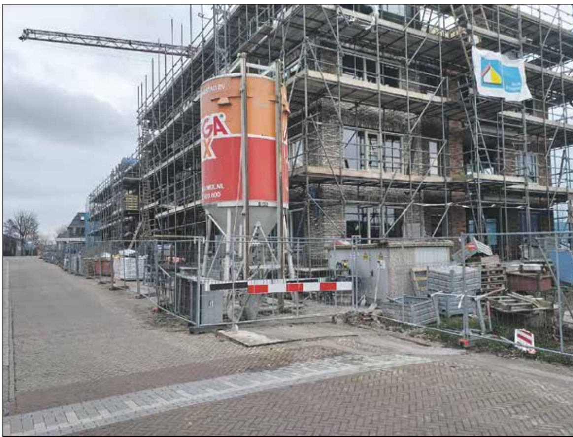
Het in aanbouw zijnde appartementencomplex te Benthuisen...
